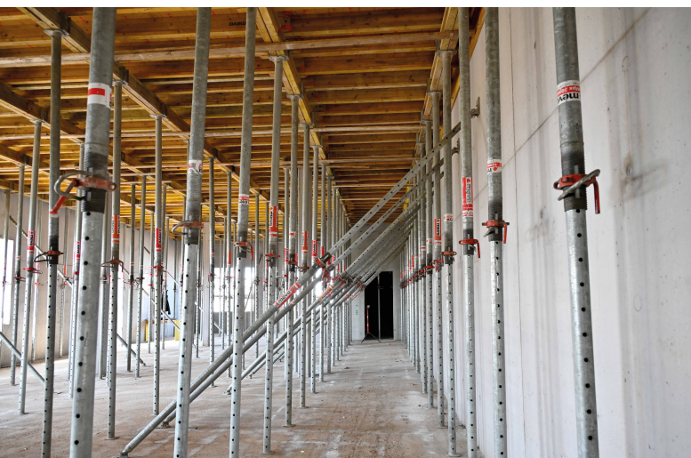
Met de klok mee vanaf linksboven: EuMax-bouwstempels worden gebruikt voor het afschoren van pas gestorte muren en voor de vloerbekisting MevaFlex. Onder de bekistingsplaat worden stempelkoppen gebruikt voor de dubbele hoofddraggers. Het personeel heeft voldoende bewegingsruimte onder de vloerbekisting.
