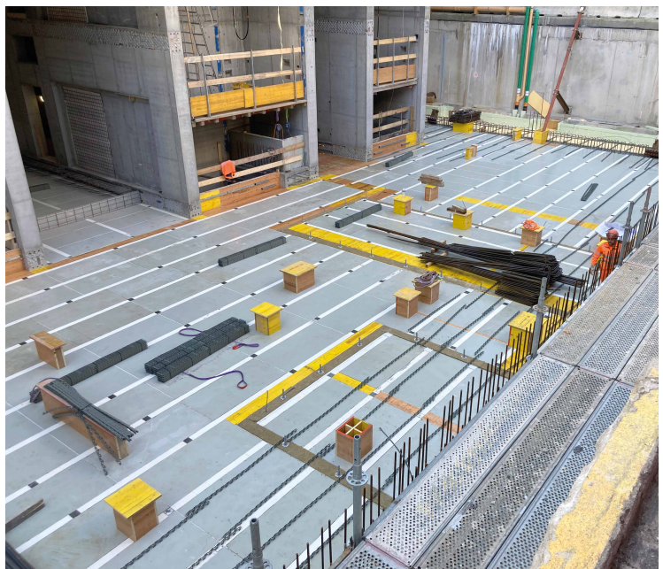
Links: het was bijzonder krap in het gedeelte van de uitkraginge stempelvloer. Rechts: alle vloeroppervlakken worden gestort met de efficiënte MevaDec bekisting.
