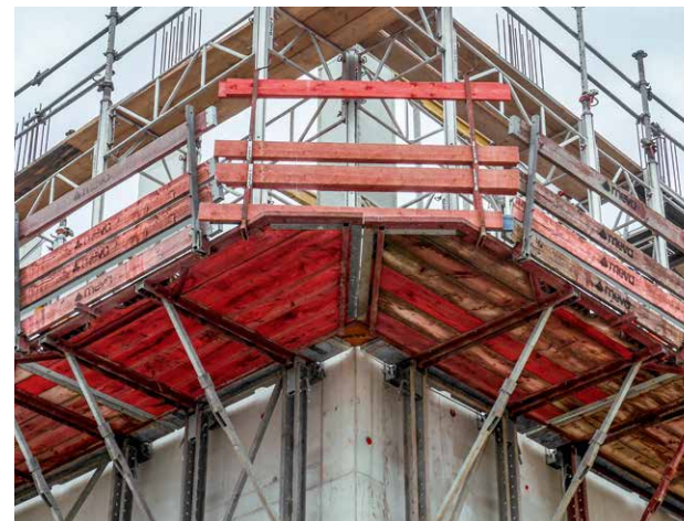
Het 190 cm brede platform biedt voldoende ruimte bij opgestelde bekisting of torensteiger. Die hoekplatforms kunnen voor rechte bouwwerkhoeken en voor stompe en spitse hoeken worden gebruikt.
