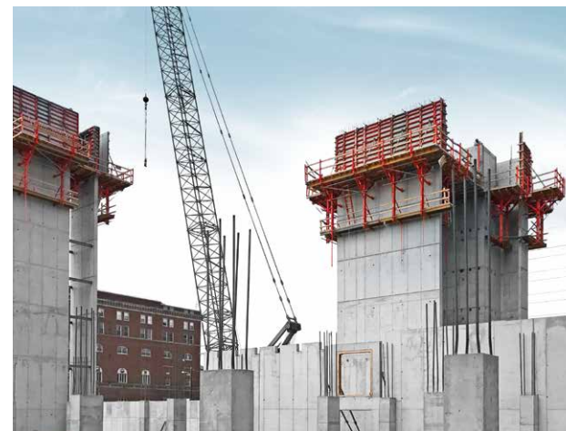
De klimsteiger KLK 230 bestaat uit klimconsoles, wandsteunen, ondergrond en railingen.
