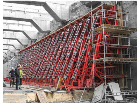
Afschoring van enkelzijdige wanden tot 13,50 m.
