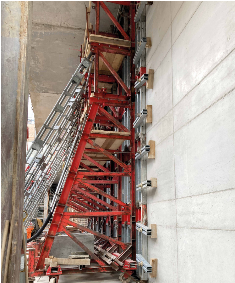
Lent, balról: A madártávlati kép a Marti cégre jellemző rendezett, szűk építési területet mutatja. A támasztóbakokat a dúcolt födém alatt és az acélpillérek között alkalmazták. Emelőtargoncával, egyszerűen görgőkön vitték a felhasználás helyére.
