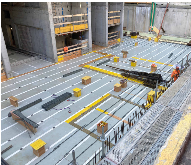
Balra: A konzolos dúcolt födémek területén különösen szűk volt a hely. Jobbra: Az összes födémeket a kiváló MevaDec zsaluval betonozták.
