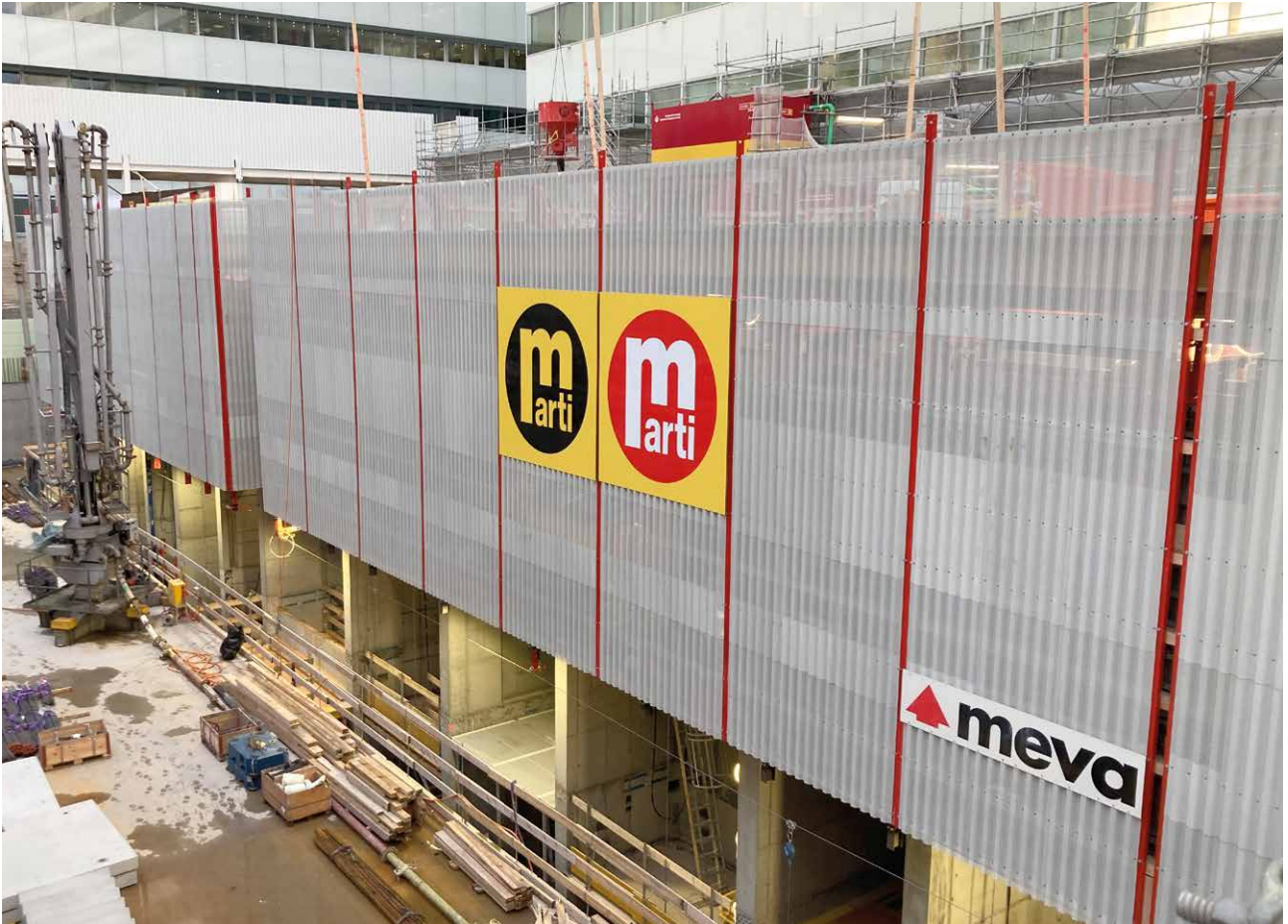
Fent: A két toronyház épületmagja párhuzamosan emelkedik a magasba a 22 méter mélységű munkagödörből. A háttérben a szomszédos magasházak homlokzatai láthatók.
