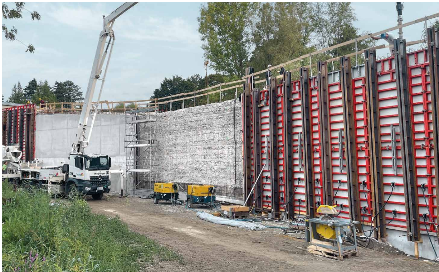
A Mammut 350 zsaluelemeket 7,5 m hosszú dupla U-szelvényekkel rögzítették.
