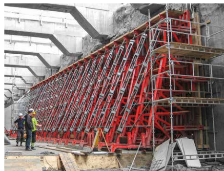
Egyoldali falak megtámasztása 13,50 m magasságig.
