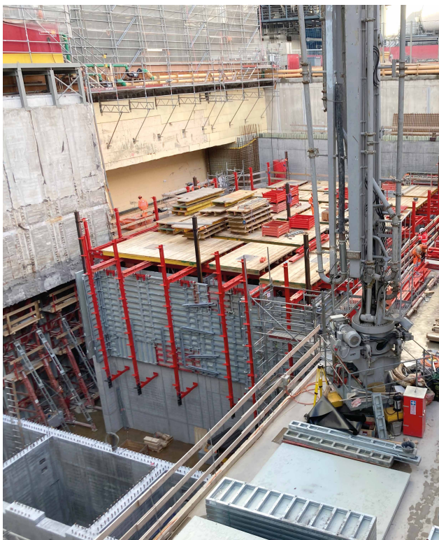
À gauche : l'autogrimpant MAC est en cours d'installation sur la dalle du noyau nord. Une fois le niveau 0 terminé, les étages vont pousser rapidement.
