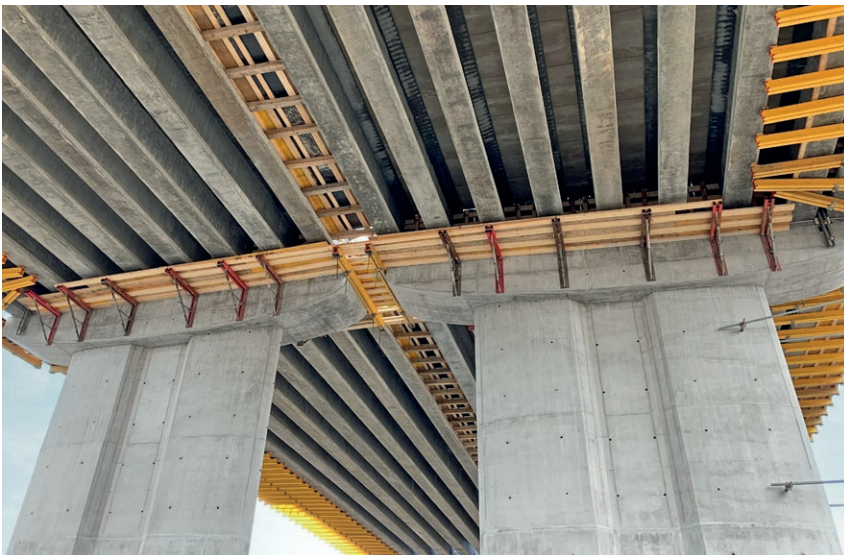
À partir de la gauche en haut, sens horaire : plusieurs systèmes MEVA ont été combinés. Le coffrage de poteaux circulaires Circo a servi à la réalisation des extrémités. Des coffrages spéciaux en bois réutilisables ont également été mis en œuvre, notamment pour les têtes des piles. La tour d'étalement MEP épouse facilement la forme elliptique des piles : le résultat est impeccable.
