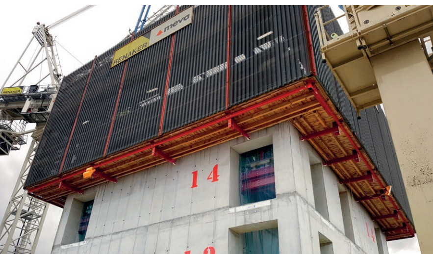
L'outil grimpant MAC en place sur le noyau. L'espace fermé offre un poste de travail confortable et sécurisé.
