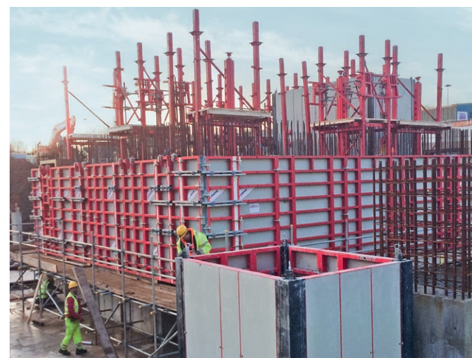
Des coffrages de trémie sont assemblés à côté du noyau avant d'être grutés vers leur lieu d'implantation.
