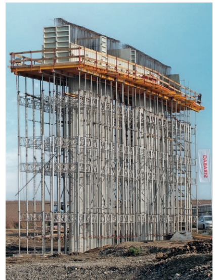
À partir de la gauche en haut, sens horaire : plusieurs systèmes MEVA ont été combinés. Le coffrage de poteaux circulaires Circo a servi à la réalisation des extrémités. Des coffrages spéciaux en bois réutilisables ont également été mis en œuvre, notamment pour les têtes des piles. La tour d'étalement MEP épouse facilement la forme elliptique des piles : le résultat est impeccable.
