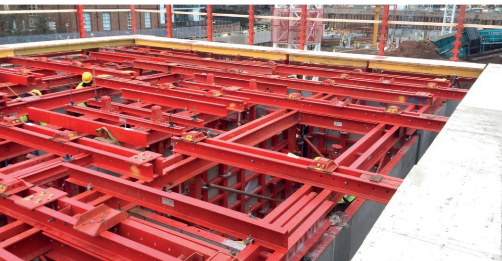
Treillis en acier utilisé pour l'accrochage du coffrage.
