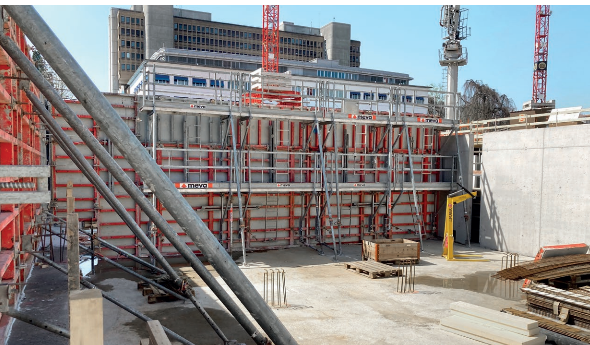
Le train de banches a été équipé du système de sécurité SecuritBasic.
