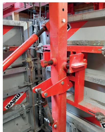
Grâce au réglage tridirectionnel qui s'effectue manuellement, le coffrage peut être mis en place avec une grande précision.
