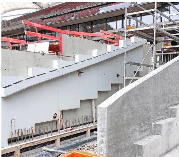
À gauche : porte-à-faux et dalles étayés par la tour d'étaie-ment MT 60. En haut à gauche : coffrage vertical Mammuth 350, tour d'étaie-ment MEP et caissons de coffrage. Photo du milieu : murs du tunnel d'accès des joueurs avec crémaillères intégrées. À droite : crémaillères coulées en place.
