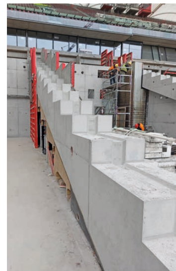
À gauche : porte-à-faux et dalles étayés par la tour d'étaie-ment MT 60. En haut à gauche : coffrage vertical Mammuth 350, tour d'étaie-ment MEP et caissons de coffrage. Photo du milieu : murs du tunnel d'accès des joueurs avec crémaillères intégrées. À droite : crémaillères coulées en place.
