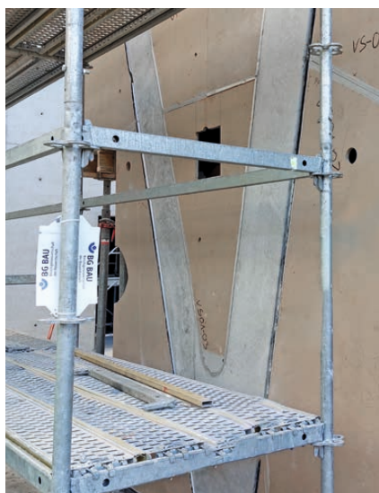
Ci-dessus : poteau en forme de V et caissons de moulage après dépose du coffrage. À droite : poteau de 50 cm de large sous crémaillère de 70 cm de large.
