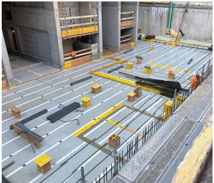
À gauche : l'espace est très exigu au niveau du porte-à-faux de la dalle de couverture. À droite : toutes les dalles ont été coulées à l'aide du coffrage de dalles modulaire MevaDec.
