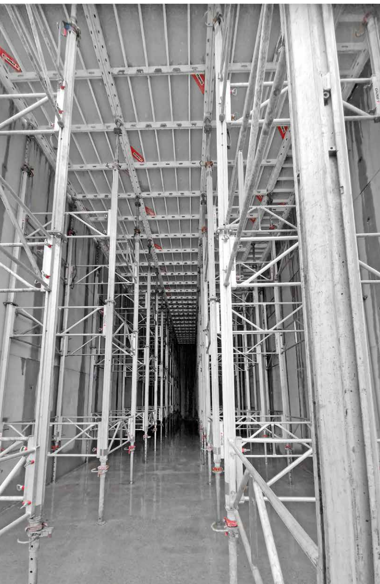
Pas de forêt d'étais avec MEP. La tour d'étaie est parfaitement adaptée aux dimensions du coffrage de dalles modulaire MevaDec.
