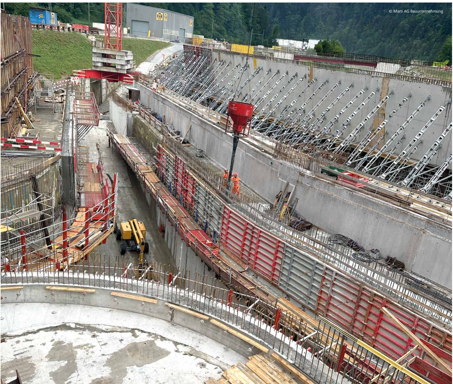
Le dégrilleur incliné est visible en haut à gauche, en dessous le barrage longitudinal qui laisse déborder le surplus d'eau dans le canal (au centre). L'eau coule entre les voiles arrondis pour être dirigée dans la galerie souterraine de 6,6 m de diamètre. La dalle recouvrant toute cette zone est en cours de réalisation, tout comme le local technique situé au-dessus de l'arrivée d'eau du tunnel. La dalle de couverture sera ensuite entièrement végétalisée, ce qui rendra l'ouvrage d'arrivée presque invisible.
