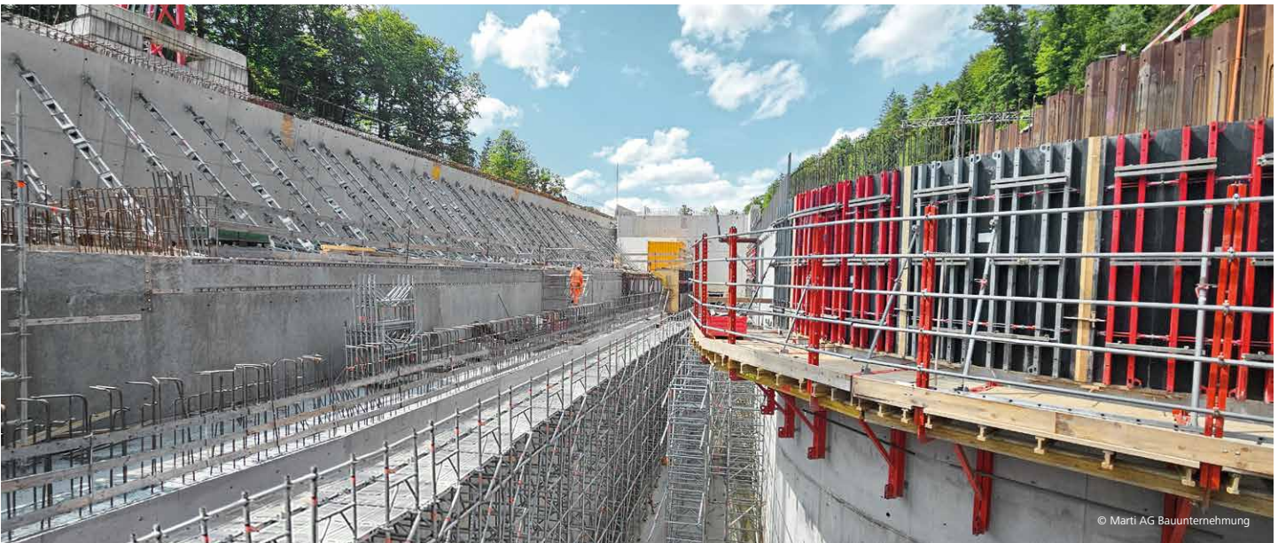
Le dégrilleur incliné est visible en haut à gauche, en dessous le barrage longitudinal qui laisse déborder le surplus d'eau dans le canal (au centre). L'eau coule entre les voiles arrondis pour être dirigée dans la galerie souterraine de 6,6 m de diamètre. La dalle recouvrant toute cette zone est en cours de réalisation, tout comme le local technique situé au-dessus de l'arrivée d'eau du tunnel. La dalle de couverture sera ensuite entièrement végétalisée, ce qui rendra l'ouvrage d'arrivée presque invisible.
