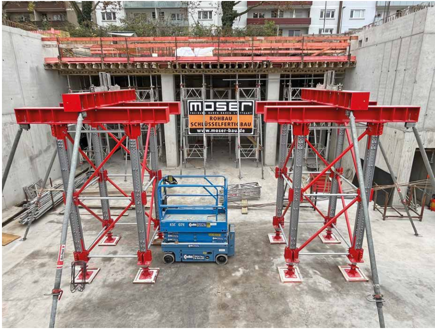
Ci-dessus : les deux tours d'étaiement MEKit ont été installées rapidement sur le chantier à Karlsruhe. Ci-dessous : le sous-sol et la poutre métallique après achèvement des travaux. Page de droite : une tour d'étaiement MEP est visible à l'arrière-plan, à droite.
