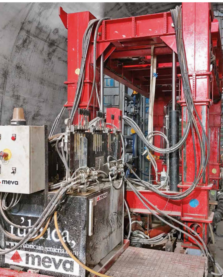
Ci-dessus : coffrage spécial au niveau de l'intersection du rameau de service et du puits vertical. En bas à gauche : entrée du coffrage de voûte en position repliée dans le rameau de secours, du sur-mesure ! Au centre : le coffrage du bloc central et de l'intersection est prêt, le chariot avec le système hydraulique est reculé. À droite : le coffrage du rameau de service a demandé de l'imagination.
