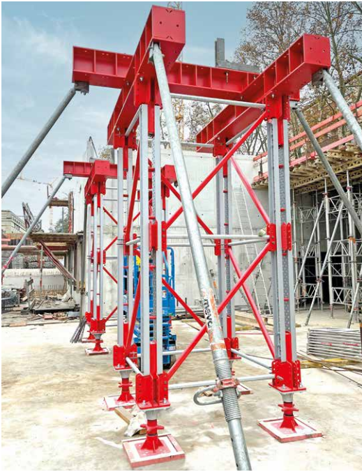
Ci-dessus : les deux tours d'étaiement MEKit ont été installées rapidement sur le chantier à Karlsruhe. Ci-dessous : le sous-sol et la poutre métallique après achèvement des travaux. Page de droite : une tour d'étaiement MEP est visible à l'arrière-plan, à droite.
