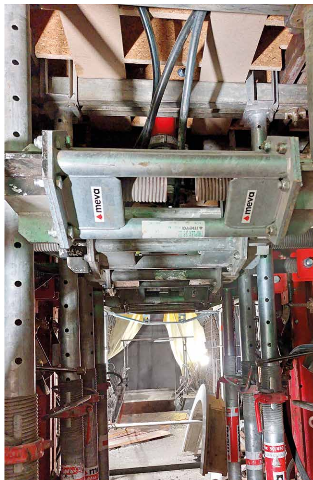
Ci-dessus : coffrage spécial au niveau de l'intersection du rameau de service et du puits vertical. En bas à gauche : entrée du coffrage de voûte en position repliée dans le rameau de secours, du sur-mesure ! Au centre : le coffrage du bloc central et de l'intersection est prêt, le chariot avec le système hydraulique est reculé. À droite : le coffrage du rameau de service a demandé de l'imagination.
