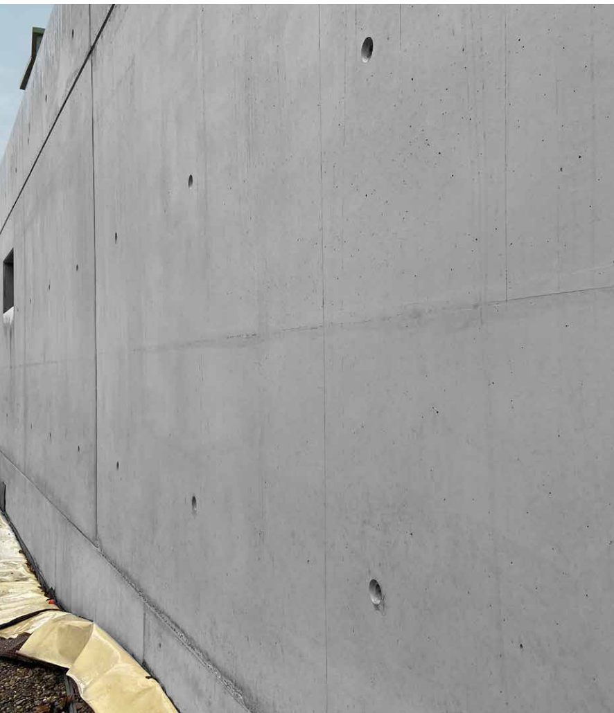
Les voiles droits séduisent grâce au calepinage esthétique des trous de banches et au parement de type P3 (SBK 3).
