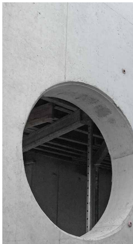
Le coffrage Mammut 350 a été habillé, sur le chantier, de panneaux en contreplaqué de bouleau.
