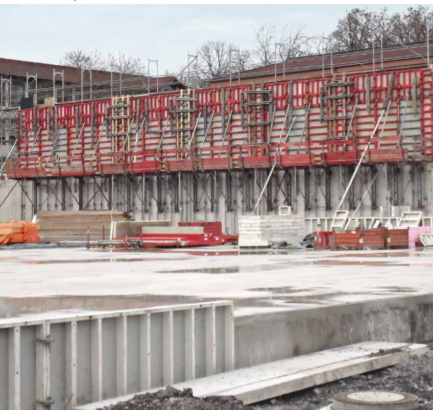
Les panneaux de coffrage Mammut 350 prennent appui sur les plates-formes de travail pliable KAB.
