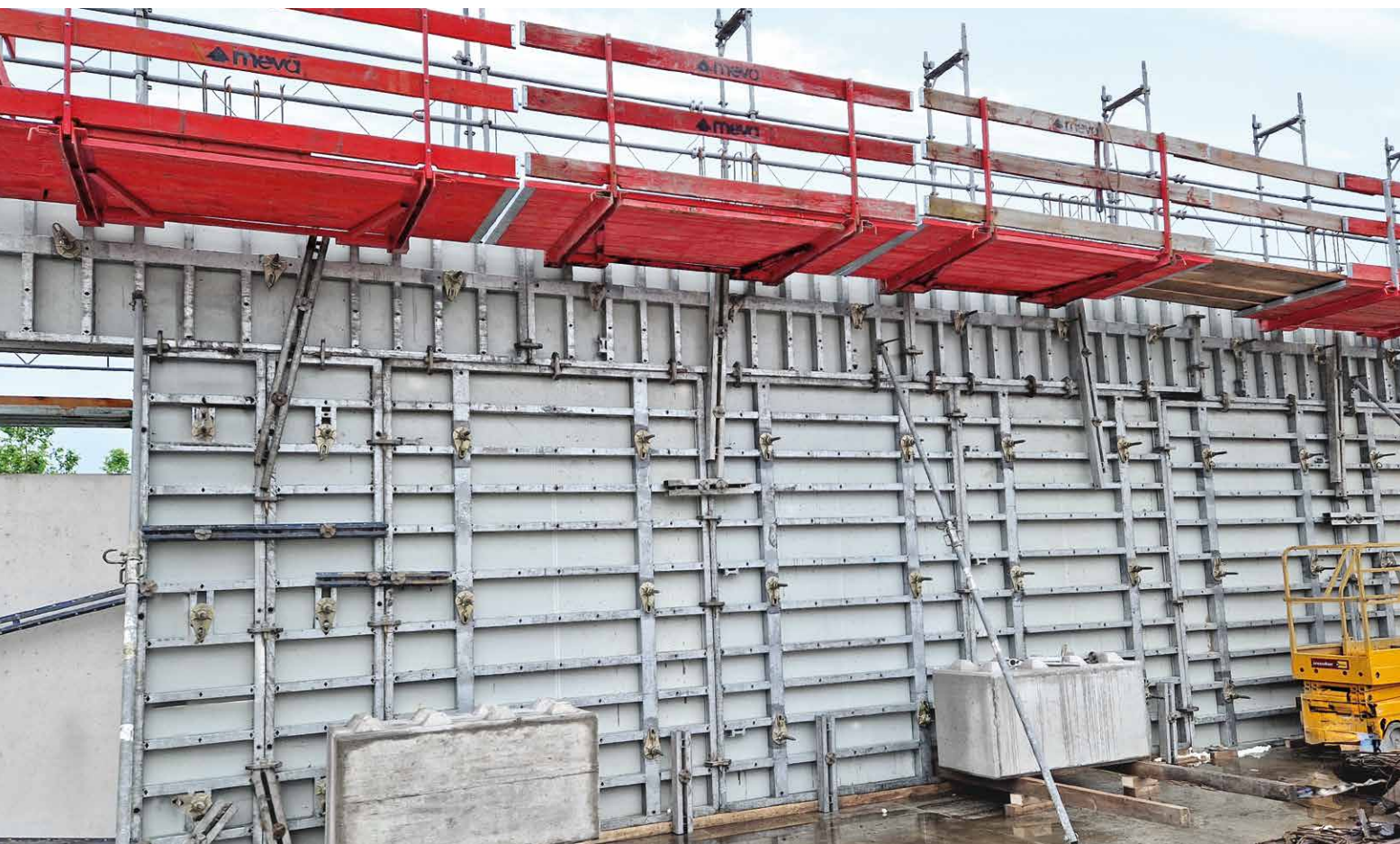
Facile et rapide à installer, la passerelle de bétonnage amovible BKB a permis de travailler en toute sécurité.
