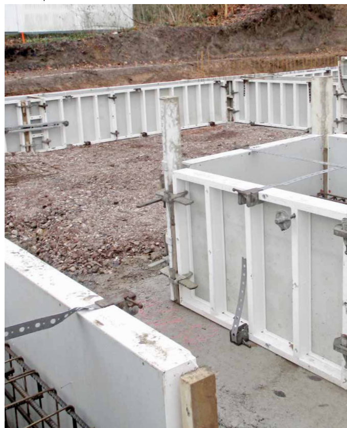
Les fondations ont été coulées avec le coffrage AluStar et des feuillards perforés.
