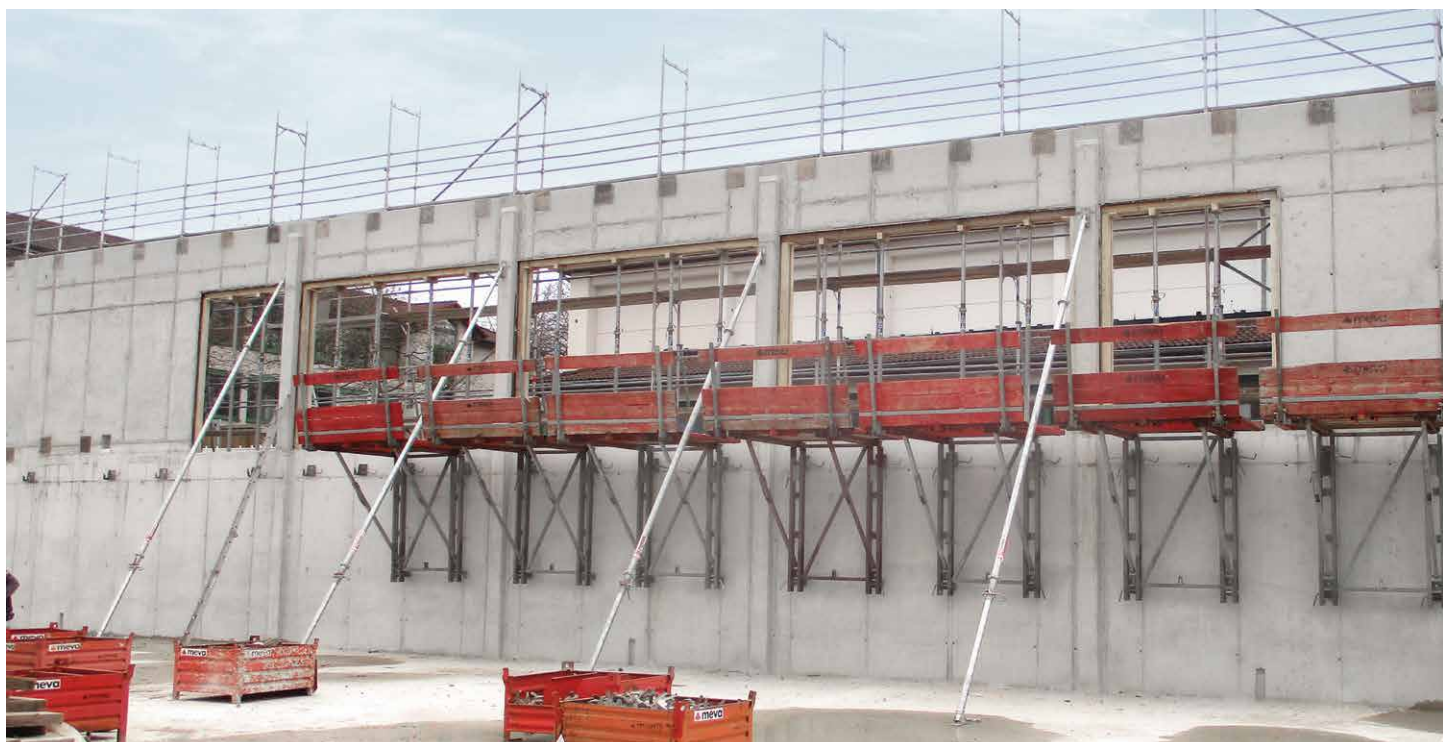
Pour la deuxième rotation de banches, des plates-formes de travail pliables KAB ont été mises en œuvre.
