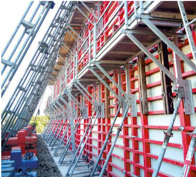
Pont routier enjambant une voie ferrée au Le Versoud, France : les coffrages Mammut 350 ont été équipés de SecuritBasic pour travailler en toute sécurité aux abords de la voie ferrée.
