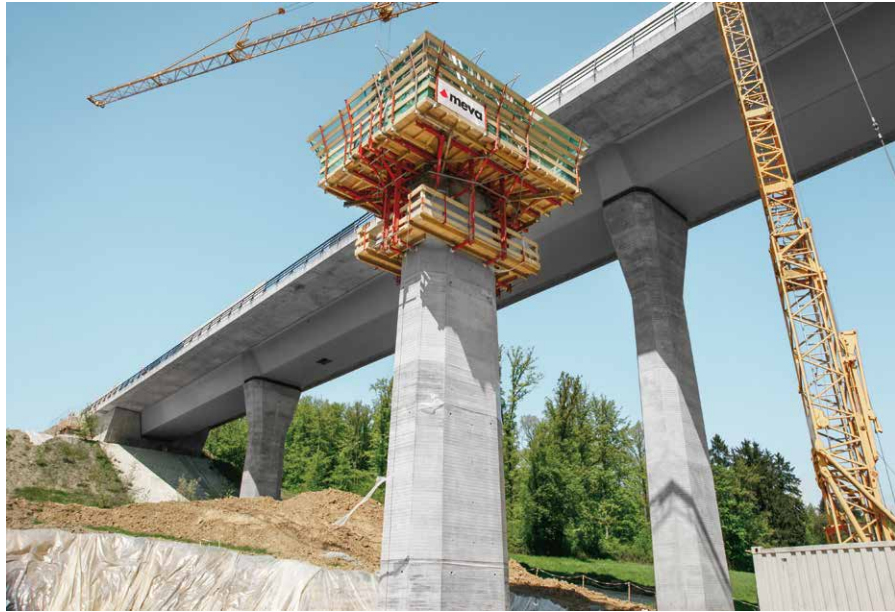
Pont sud du Dultenaugraben à Rheinfelden, Allemagne (échafaudage grim pant KLK 230).
