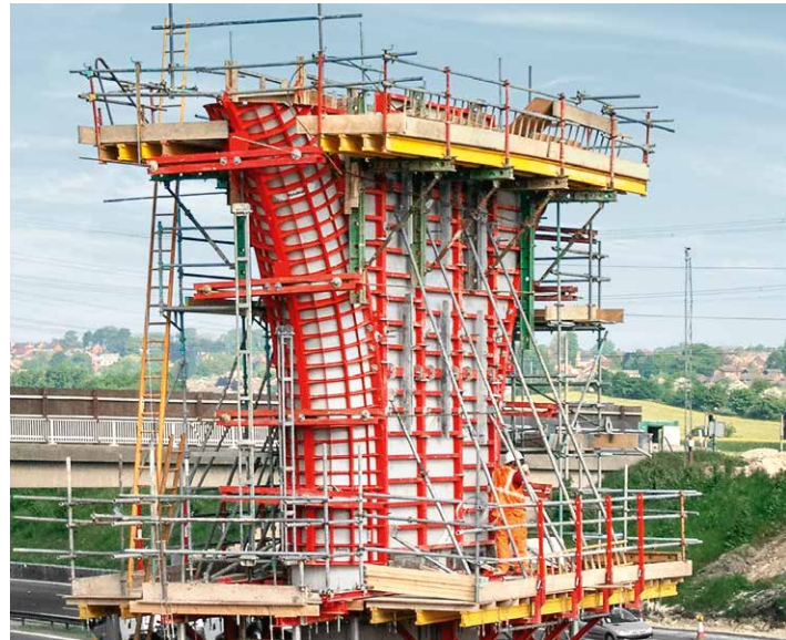
Pile de pont à Ferrybridge, Grande-Bretagne.
