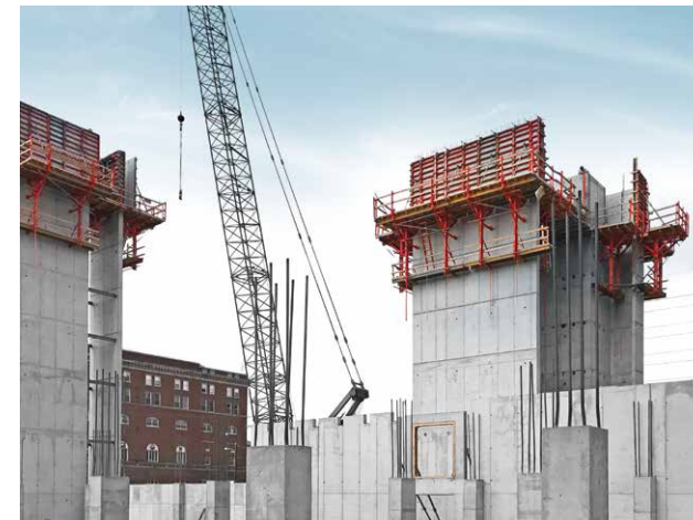
L'échafaudage grim pant KLK 230 est composé de consoles grim pant, d'étais muraux, d'un platelage et de garde-corps.
