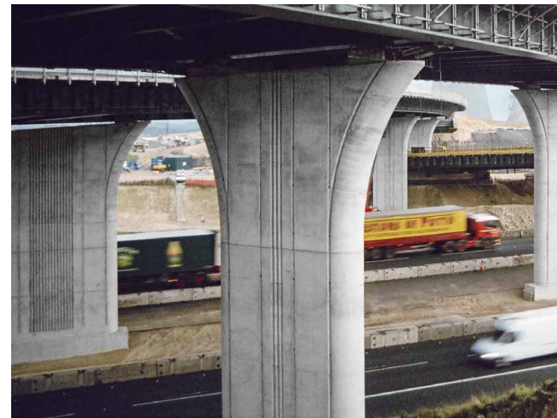
À partir du coffrage de poteaux circulaires Circo, il est possible de fabriquer un coffrage spécial pour coffrer des ouvrages aux lignes courbes et inclinées. Comme pour l'échangeur autoroutier de Holmfield, Royaume-Uni.
