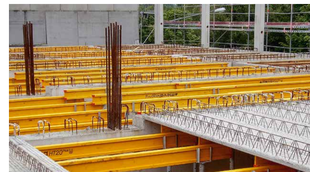
MevaFlex est idéal pour l'étaie des prédalles en béton.
