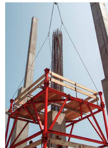
Grutage de modules préassemblés : adaptation rapide à la hauteur de l'ouvrage.
