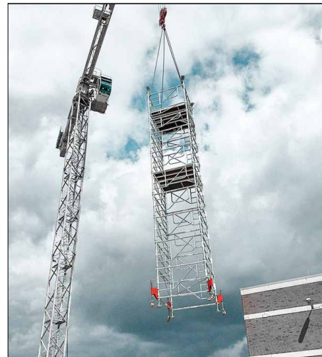
Anneaux de levage intégrés sur chaque cadre
