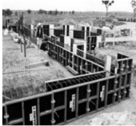
Fig. 28.1 Utilisation pour fondations
