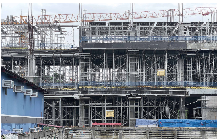
Arriba: el Boracay Convention Centre fue entregado según lo previsto por MEVBUILT. A la derecha: las columnas del edificio se levantaron usando el encofrado para muros AluFix que es ligero y prescinde de grúas, impresionando a los trabajadores involucrados con sus superficies de concreto uniformes y limpias.
