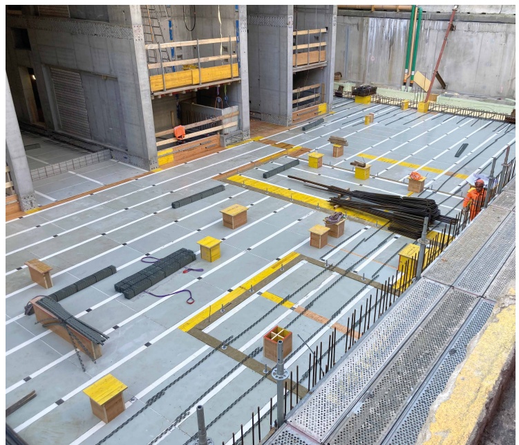
A la izquierda: el área del refuerzo perimetral con saliente era muy estrecha. A la derecha: Todas las losas se encofran con el eficiente encofrado MevaDec.
