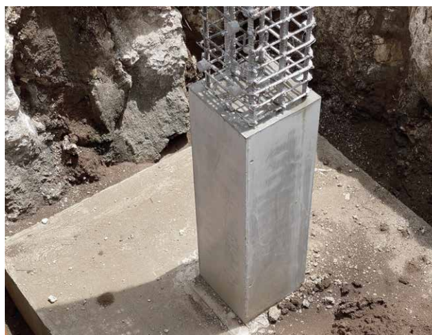
Arriba: el Boracay Convention Centre fue entregado según lo previsto por MEVBUILT. A la derecha: las columnas del edificio se levantaron usando el encofrado para muros AluFix que es ligero y prescinde de grúas, impresionando a los trabajadores involucrados con sus superficies de concreto uniformes y limpias.
