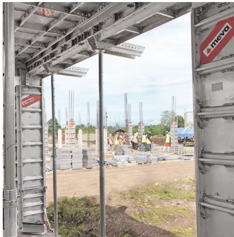
Las ventanas y las puertas simplemente se recortan, los balcones, las columnas y las vigas pueden confeccionarse según se requiera. Todo con MonoFix.
