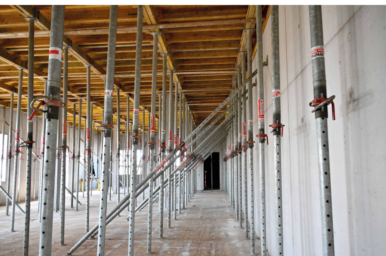
Von links oben im Uhrzeigersinn: EuMax-Baustützen werden für die Abstützung frisch betonierter Wände ebenso genutzt wie für die Deckenschalung MevaFlex. Unter der Schalung sind Stützenköpfe für Doppeljoche im Einsatz. Das Personal verfügt über viel Bewegungsfreiheit unter der Deckenschalung.
