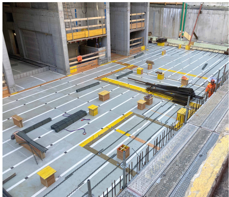
Links: Im Bereich der auskragenden Sprießdecke ging es besonders eng zu. Rechts: Alle Decken werden mit der effizienten MevaDec-Schalung betoniert.
