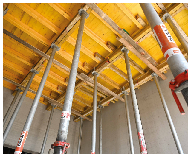
Von links oben im Uhrzeigersinn: EuMax-Baustützen werden für die Abstützung frisch betonierter Wände ebenso genutzt wie für die Deckenschalung MevaFlex. Unter der Schalung sind Stützenköpfe für Doppeljoche im Einsatz. Das Personal verfügt über viel Bewegungsfreiheit unter der Deckenschalung.
