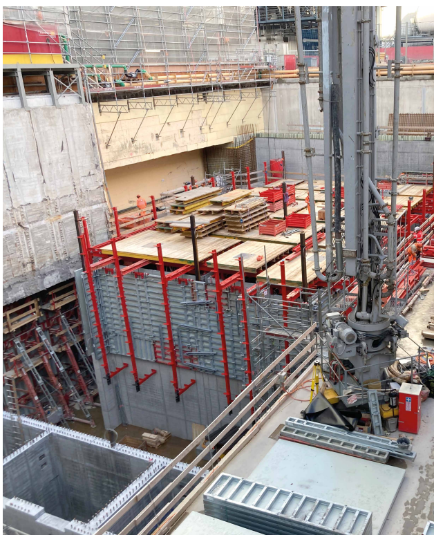
Links: Auf dem untersten, fertig betonierten Geschoss wird das MAC für den Nordkern bereits aufgebaut. Nach Erreichen der Null-Ebene geht es mit den Regelgeschossen zügig in die Höhe.
