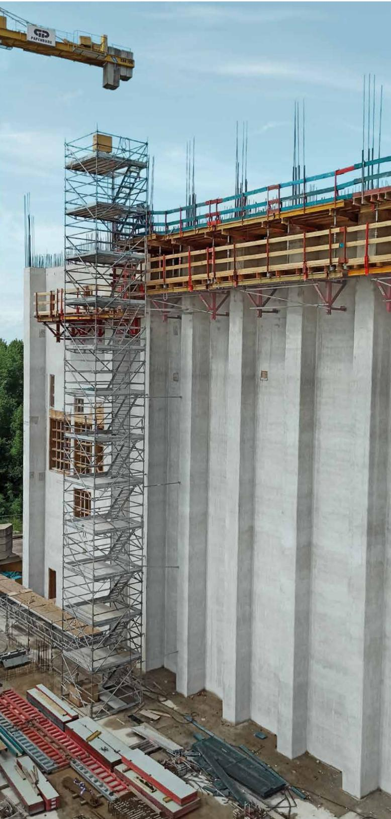
**Für die Errichtung von Fundamenten, Wänden und Decken einer Klärschlammverbrennungsanlage in Hannover waren sichere und schnelle MEVA-Lösungen gefragt. Der Bau eines Kranbahnbalkens in 21 m Höhe krönte das Projekt.**
