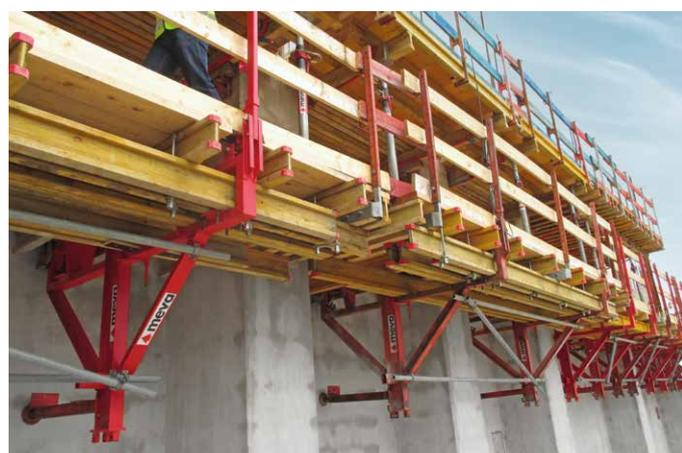
Die Klapparbeitsbühnen KAB 190 (oben) und das exakt an die Störstellen angepasste Klettergerüst KLK 230 boten reichlich Arbeitsraum.
