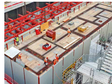
Die oberste Fläche ist bei MAC frei von Klettermasten und bietet so optimale Sicherheit, minimales Unfallrisiko und mehr Lagerfläche.
