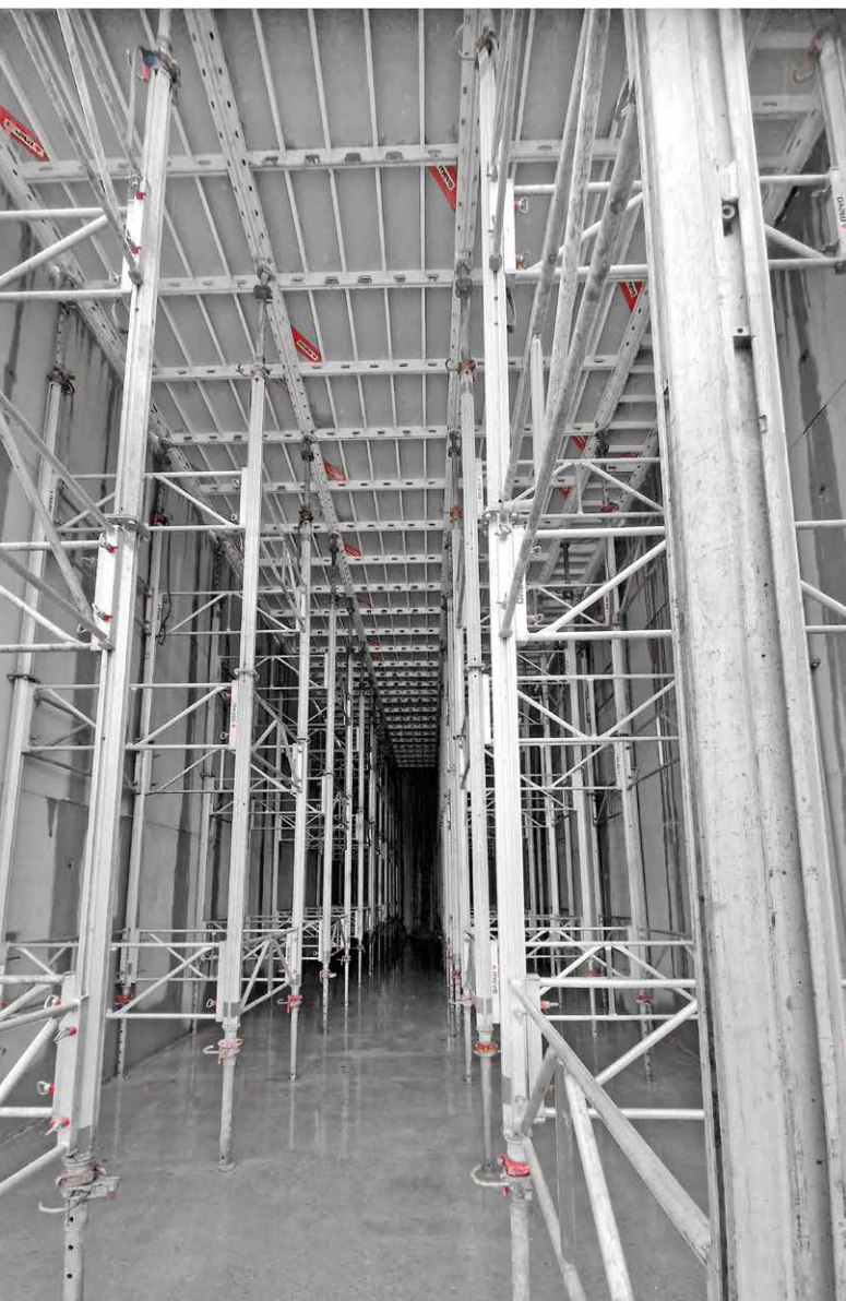
MEP erzeugt keinen „Stützenwald“. Das Traggerüst ist genau mit den Systemmaßen der Deckenschalung MevaDec abgestimmt.
