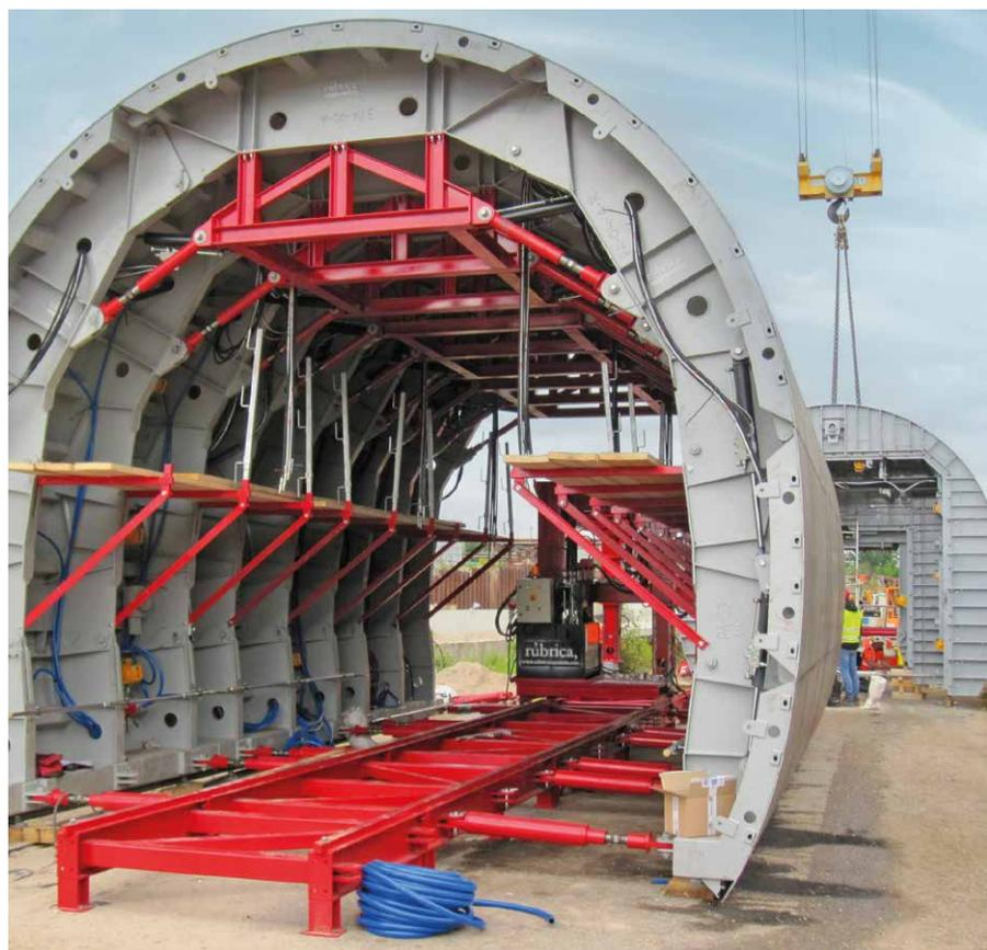
Eines von drei Gewölbeschalungssegmenten im ausgeklappten Zustand. Hinten rechts ist die monolithische Schalung für Mittel- und Anschlussblöcke mit Stirnschalung zu erkennen.
