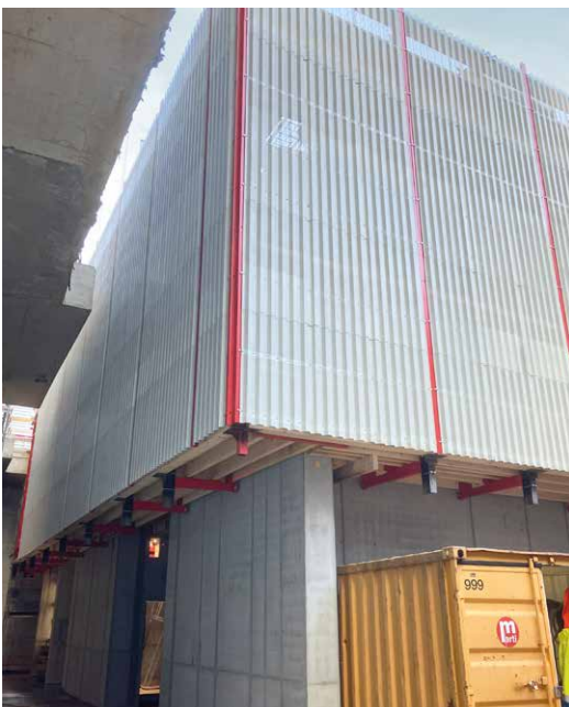
Links: Im Bereich der auskragenden Sprießdecke ging es besonders eng zu. Rechts: Alle Decken werden mit der effizienten MevaDec-Schalung betoniert.
