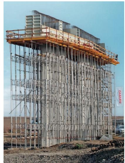
Von links oben im Uhrzeigersinn: Mehrere MEVA-Systeme wurden kombiniert. Die Säulenschalung Circo bildete die äußeren Abschlüsse. Mehrfach verwendbare Sonderschalungselemente aus Holz, hier Teile davon für die Pfeilerköpfe, kamen zum Einsatz. Das Traggerüst MEP passte sich problemlos an die elliptische Pfeilerform an. Das Resultat: eins!
