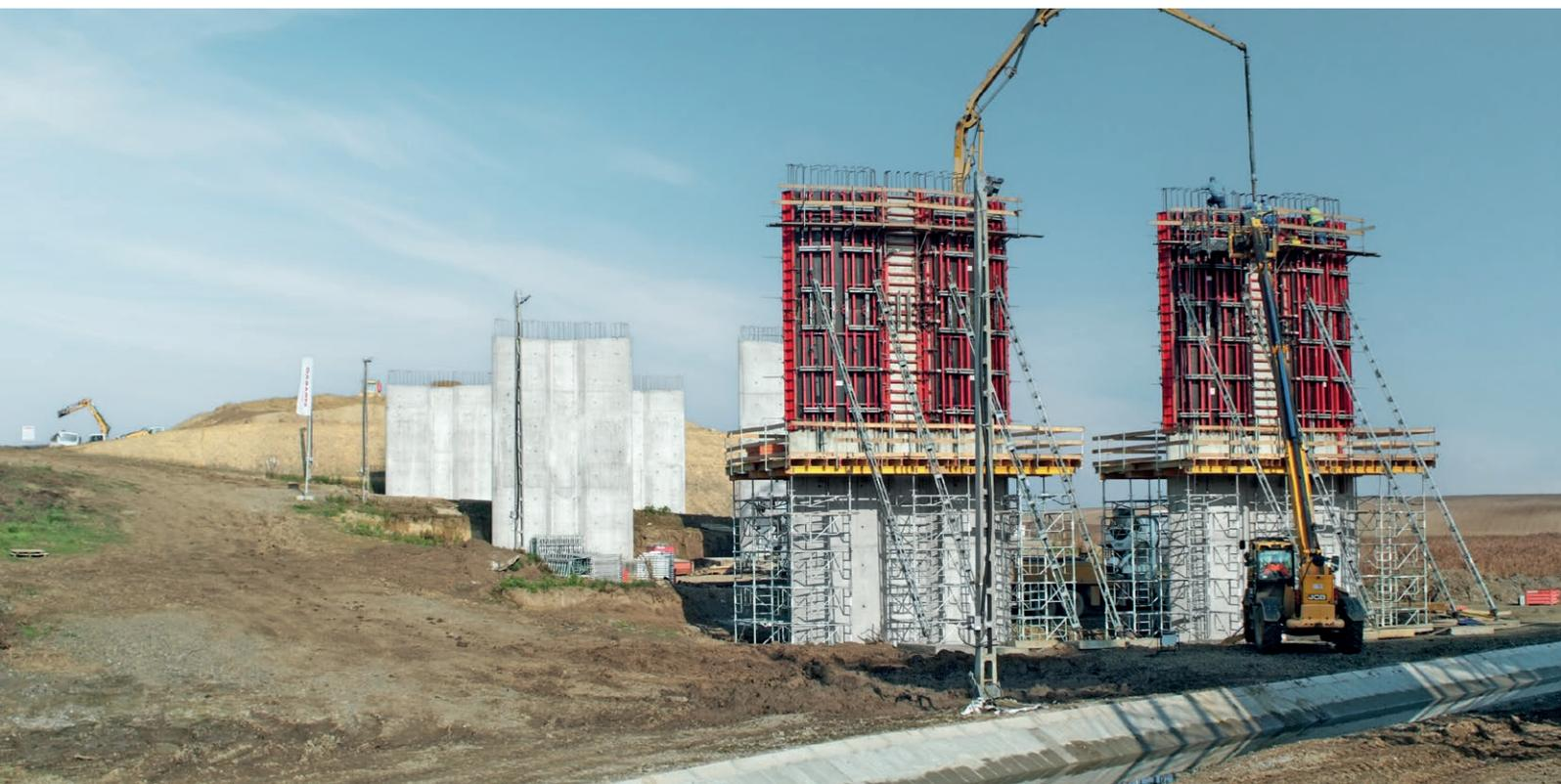
Schalung und Arbeitsbühnen werden vom Traggerüstsystem MT 60 unterstützt, Schrägstützen Triplex tragen den Frischbetondruck ins Erdreich ab.
