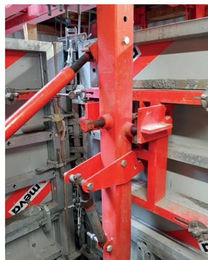
Mithilfe der manuellen Drei-Wege-Justierung wird die Schalung exakt ausgerichtet.
