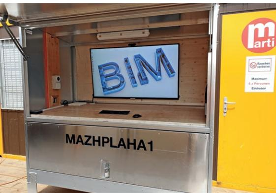
Links oben: Das Kantonsspital wird gemäß dem aktuell höchsten Baustandard Minergie P-ECO errichtet. Oben: Das Spital ist das bisher größte mit BIM-2-field-Methode umgesetzte Projekt des Totalunternehmers Implenia AG. Links: Monitor, Tastatur, Maus: eines von fünf auf der Baustelle verteilten „BIM-Plan-Hüsli“.
