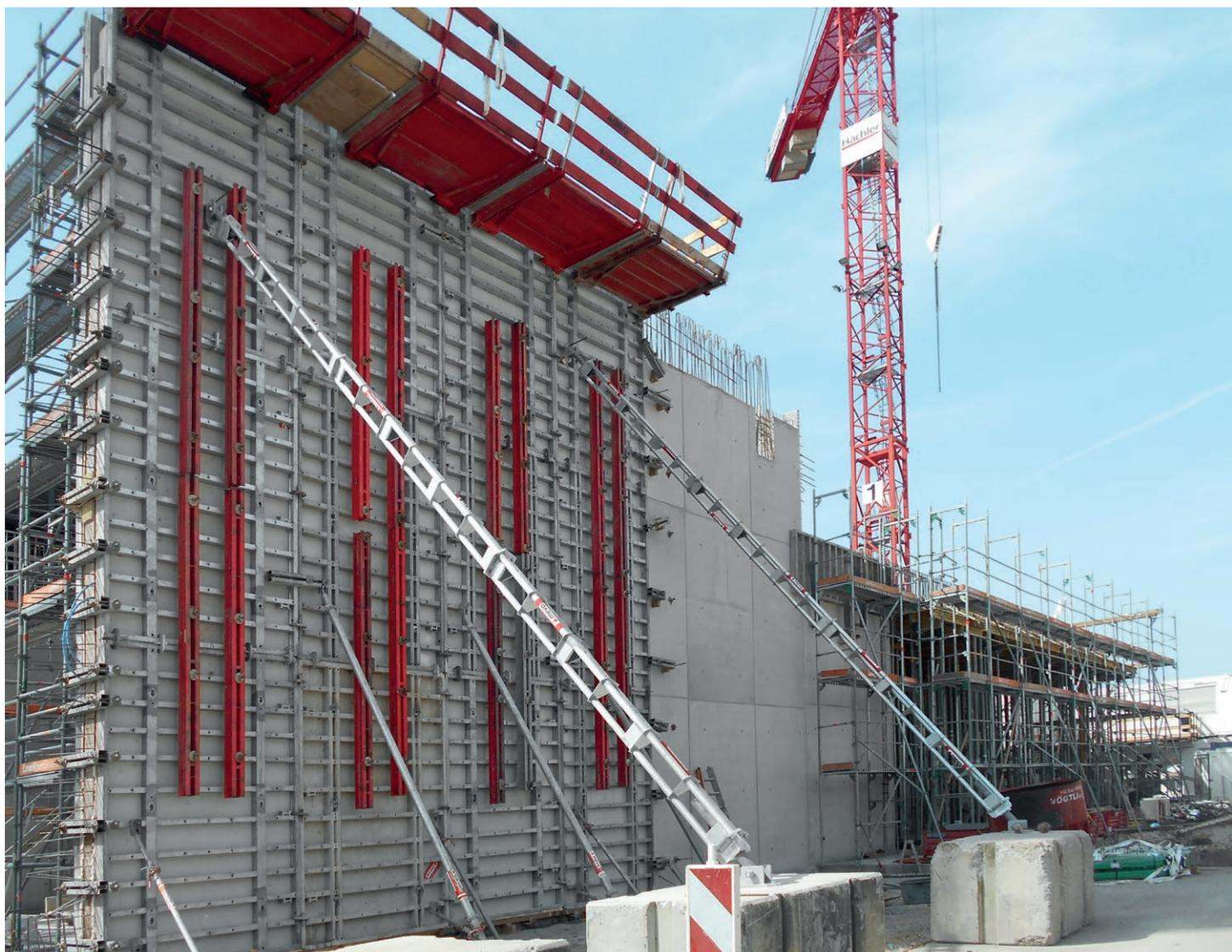
Fotos links unten: Mit der 13,80 m hohen ersten Wandetappe wurden Zeit und Aufwand deutlich reduziert. Die 55 cm dicken Wände wurden frei stehend mit Mammut XT errichtet. Oben: Die KAB-Klapparbeitsbühnen sind vom Stapel aus einsatzbereit, die Plattform klappt aus und verriegelt automatisch. Triplex-Schrägstützen sorgten für die sichere Ableitung des Frischbetondrucks ins Fundament.
