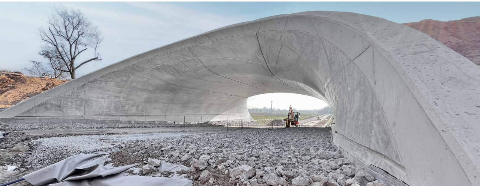
Rad- und Fußweg-Unterführung in Mannheim, gebaut mit cleverer Kombination von Sonder- und Standardschalung.
