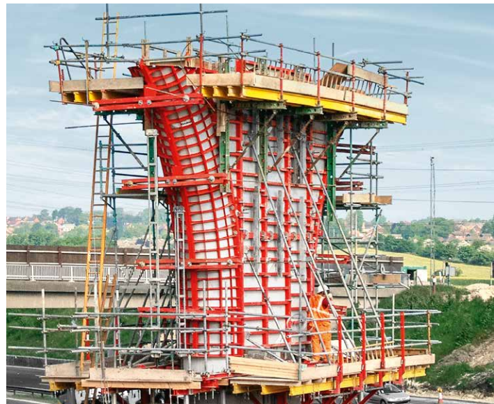
Brückenpfeiler in Ferrybridge, Großbritannien.
