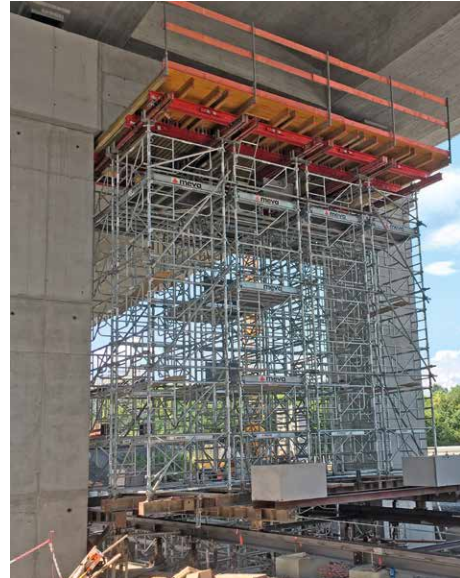
Autobahnbrücke bei Heilbronn, Traggerüst MT 60, auf Schienen verfahrbar.
