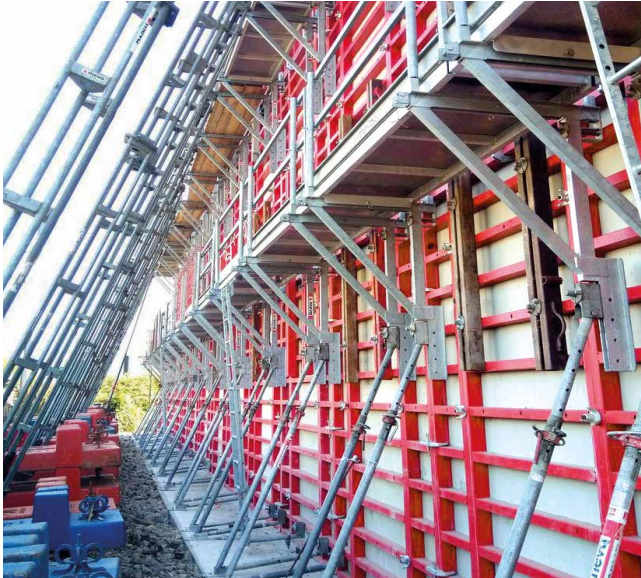
Straßenbrücke über eine Bahnstrecke in Versoud, Frankreich, mit schlankem Aufbau von Mammut 350 und SecuritBasic für sicheres Arbeiten unmittelbar am Bahngleis.
