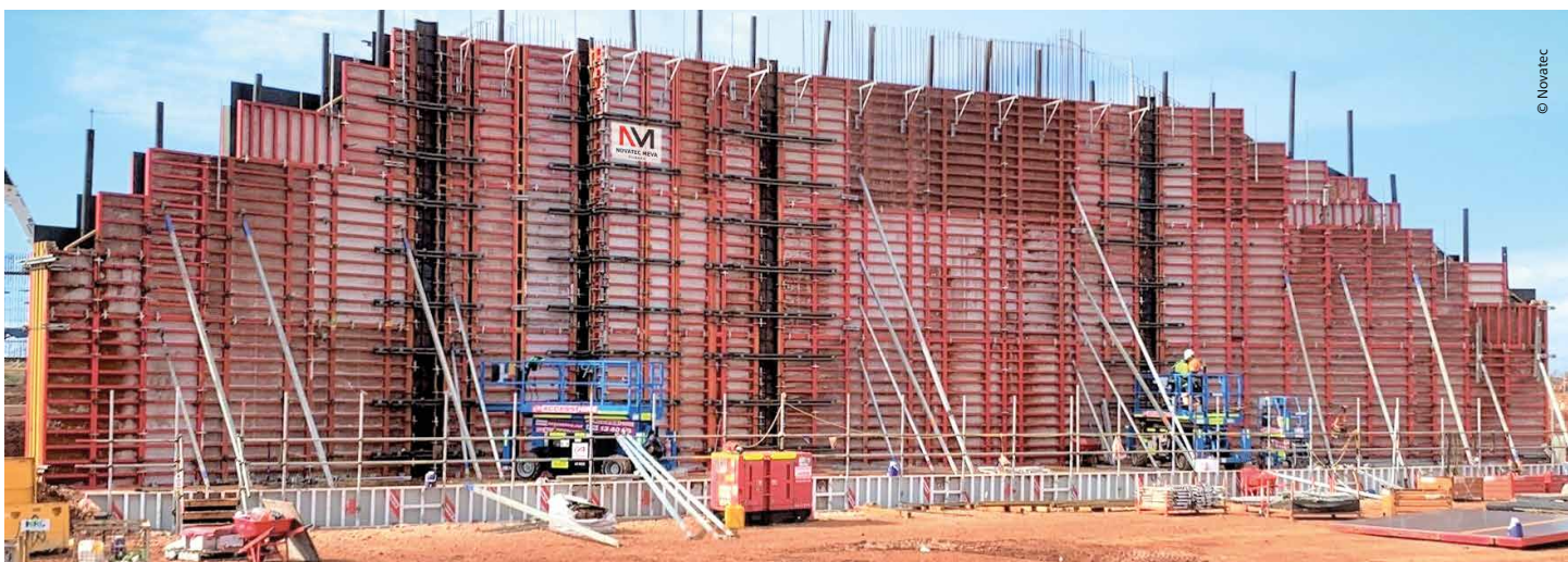
Widerlager Eisenbahnbrücke, Bergbauregion Pilbara, Australien (Mammut 350).
