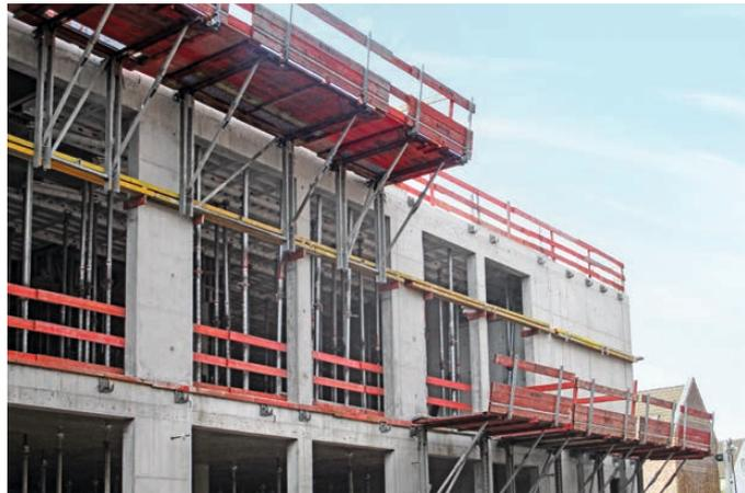
Unterstockung einfach von unten verlängert oder verkürzt. Integrierte Sicherheitsfunktionen wie die Arbeitsplattform mit integrierter Aufstiegsleiter sorgen für reibungslosen Projektlauf. Nach dem Ausschalen wird die komplette Einheit mithilfe von Anklemmrädern einfach zum nächsten Einsatzort verfahren oder per Kranhub auf das nächsthöhere Geschossniveau transportiert.
