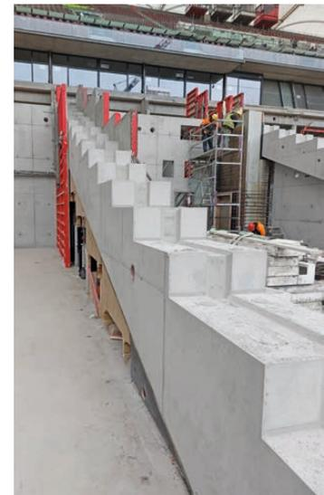
Links: Das Traggerüst MT 60 stützte Überhänge und Decken ab; oben links: Stellschalung Mammut 350, Traggerüst MEP und Bodenkästen; Mitte: Brüstungen des Spielereingangstunnels mit integrierten Zahnbalke; rechts: fertig betonierte Zahnbalke.
