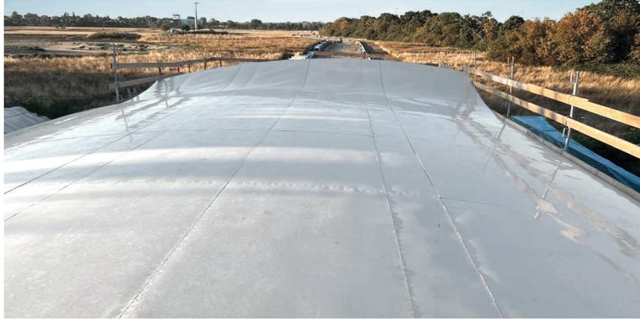
Obere Bildreihe: Zahlreiche Sonderschalelemente aus Holz wurden mit alukas SF Flex-Platten belegt und nach Vorgabe von 3-D-Zeichnungen angeordnet und aufgebaut.
