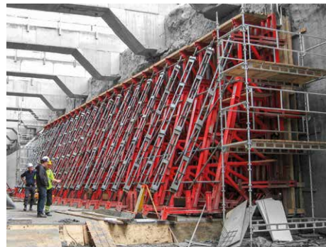
Abstützung von einhäuptigen Wänden bis 13,50 m.
