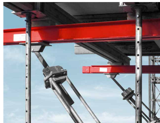
Triplex als Unterstützung für Plattformen, bei auskragenden Decken und schwebenden Balkonen.
