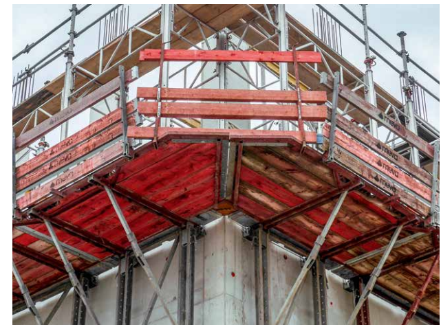
Die 190 cm breite Bühne bietet genügend Platz bei aufgestellter Schalung oder Rahmengerüst. Die Eckbühnen können für rechtwinklige Bauwerksecken sowie für stumpfe und spitze Winkel eingesetzt werden.
