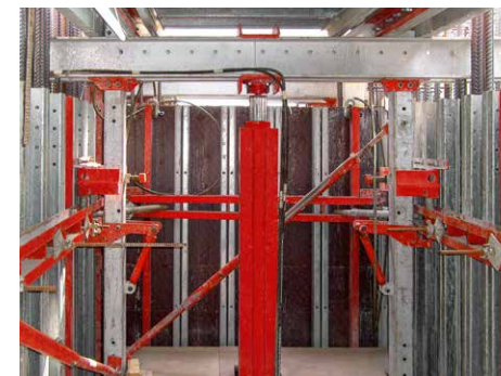
Hochleistungshydraulik des automatischen Klettersystems MAC ermöglicht einen 4,5 m langen Hub (20 t pro Zylinder).
