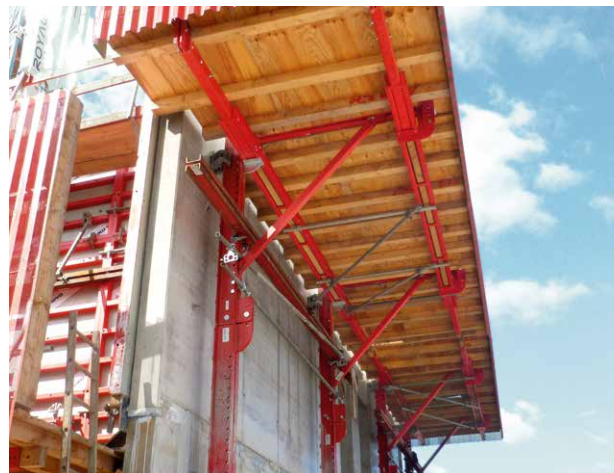
Immer fest am Gebäude verankert, sowohl in der Bau- als auch Kletterphase.
